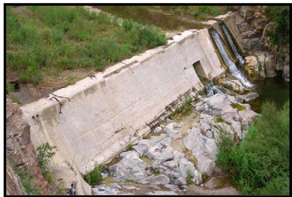
Figure 27 : seuil de Cascacastel sur la Berre (MRM)
